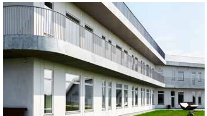
Din Forsyning Esbjerg. Friis & Moltke Architects. Foto: Inhouse Fotografi
